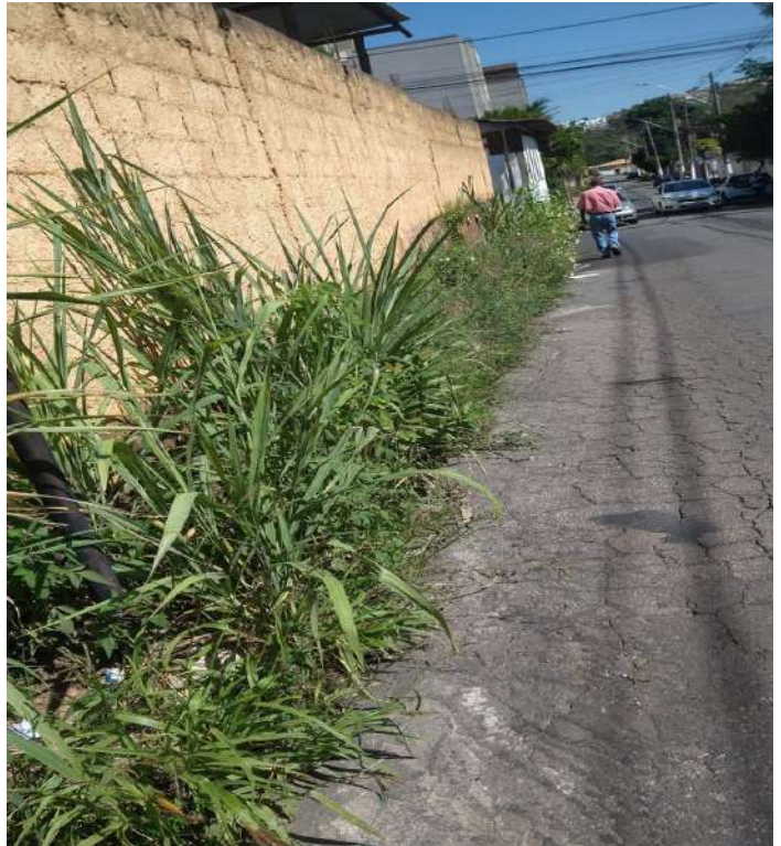
Foto 5. Rua João XXIII
