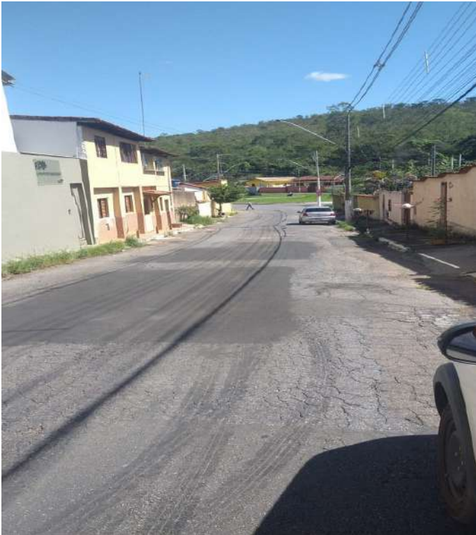
Foto 4. Rua João XXIII
