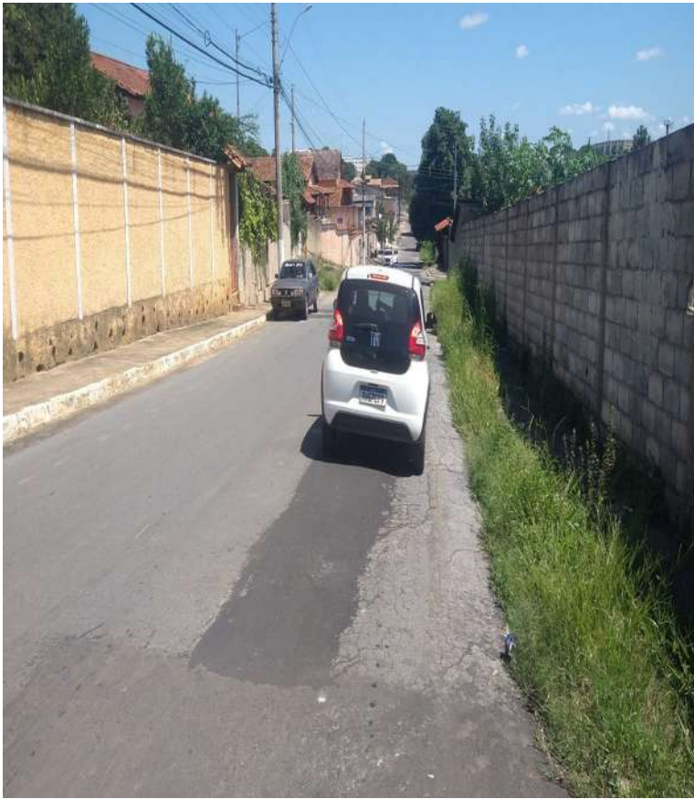
Foto 2. Rua Ismar Francisco Santos
