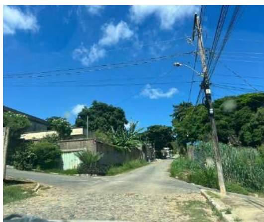
Foto 6 - Rua Cel. Dirceu Paiva
