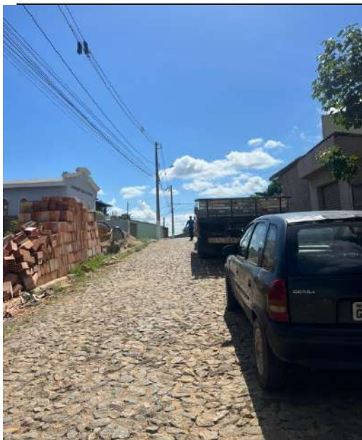
Foto 3 - Rua Cel. Dirceu Paiva
