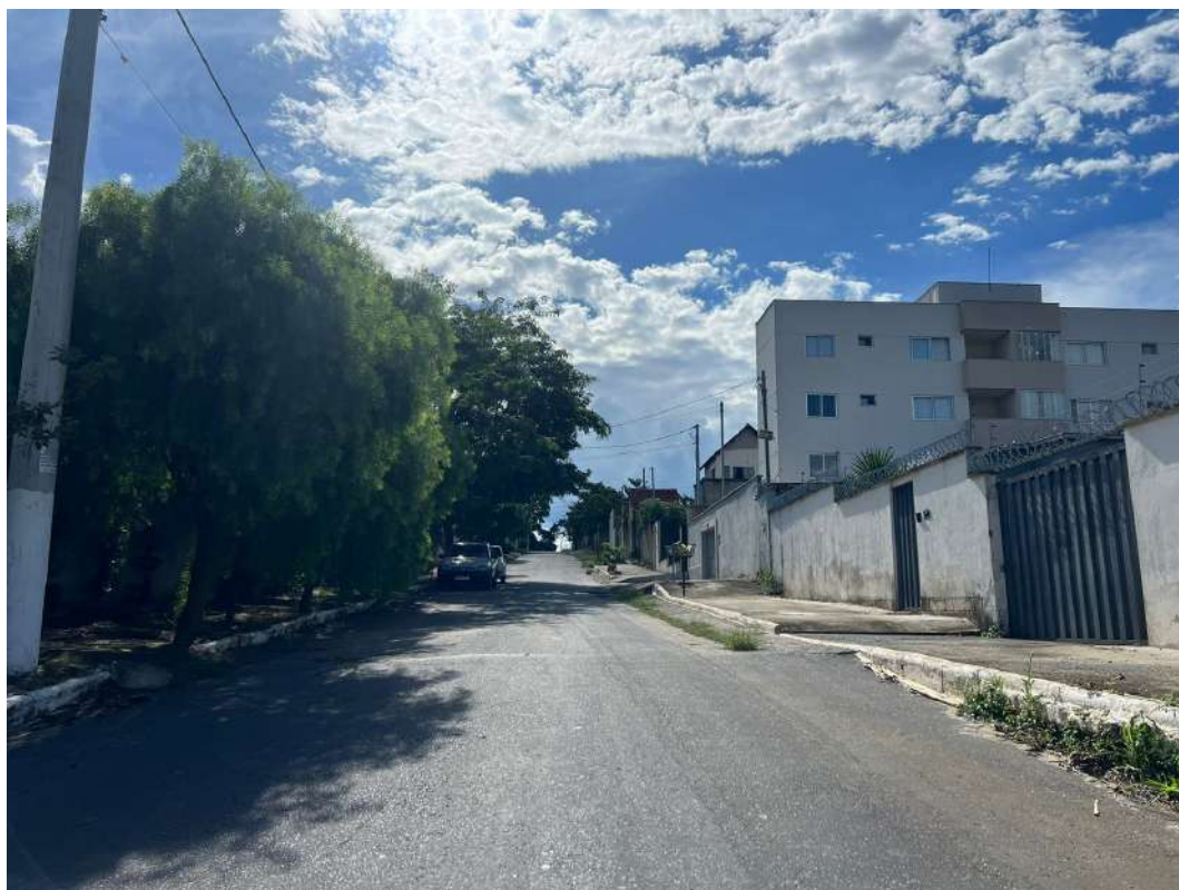
Foto 2 - Rua Bartolomeu Bueno de Gusmão
