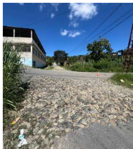
Foto 7 - Rua Cel. Dirceu Paiva
