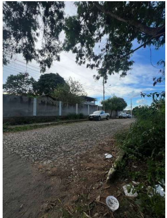
Foto 6 - Rua dos Coqueiros
