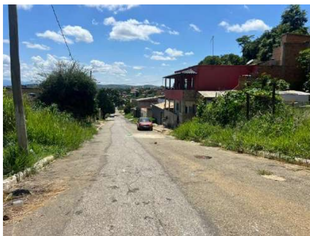
Foto 8 - Rua Cel. Dirceu Paiva
